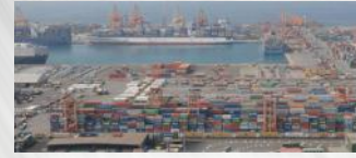
Saudi Jeddah Port
